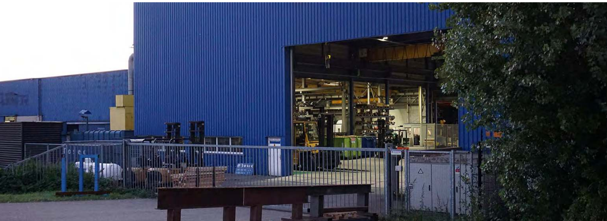
Afb. 5. Via industriedeuren die vaak en soms lang geopend zijn, gaat soms veel warmte (en koude) verloren.
