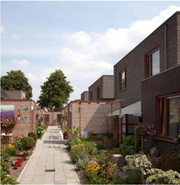
ERA Contour heeft in opdracht van Stadlander 34 energieneutrale nultredewoningen gebouwd in Steenberg.
