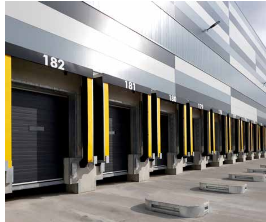
Alle 82 geconditioneerde laad- en losserrons zijn voorzien van opblaasbare dock shelters en automatische overheaddeuren met hoogwaardig geïsoleerde panelen.
