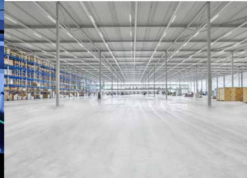
Dankzij slimme sensoren stemmen de LED-lichtlijnen en High Bay LED-armaturen hun lichtoutput zelfstandig af op het aanwezige daglicht.
