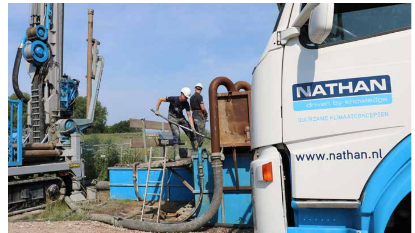
Bronboringen t.b.v. de aanleg van een warmtekuideopslag (WKO).
