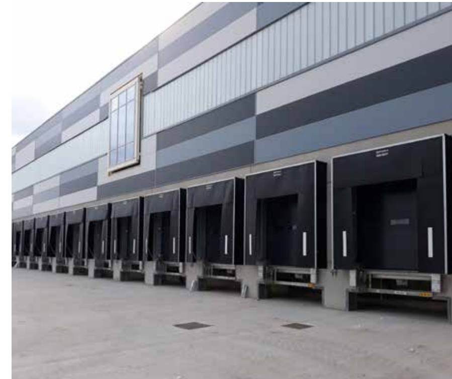
Mechanische dock shelters met standaard geïsoleerde overheaddeuren.
