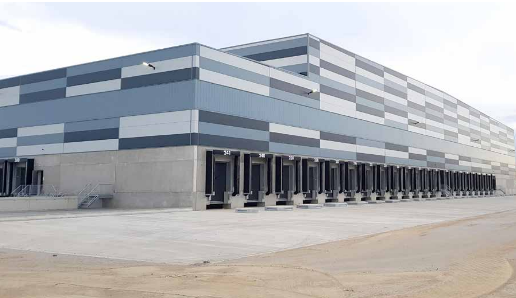
"De onderste vier meter van de gevel is gemaakt van beton. Daarboven hebben we sandwichpanelen in drie tinten grijs gemonteerd."
