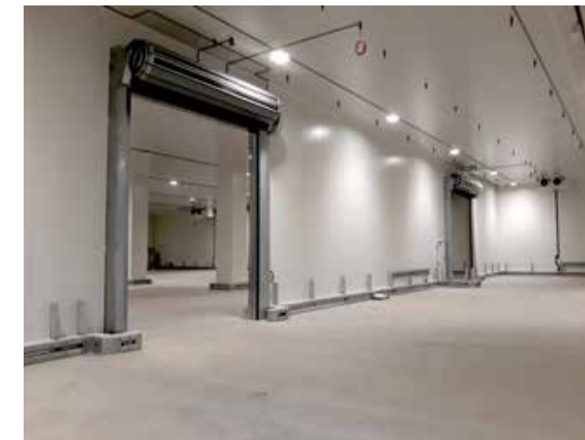
Op de voorgrond: een geïsoleerde snelroldeur, met op de achtergrond de extra geïsoleerde overheaddeuren.
