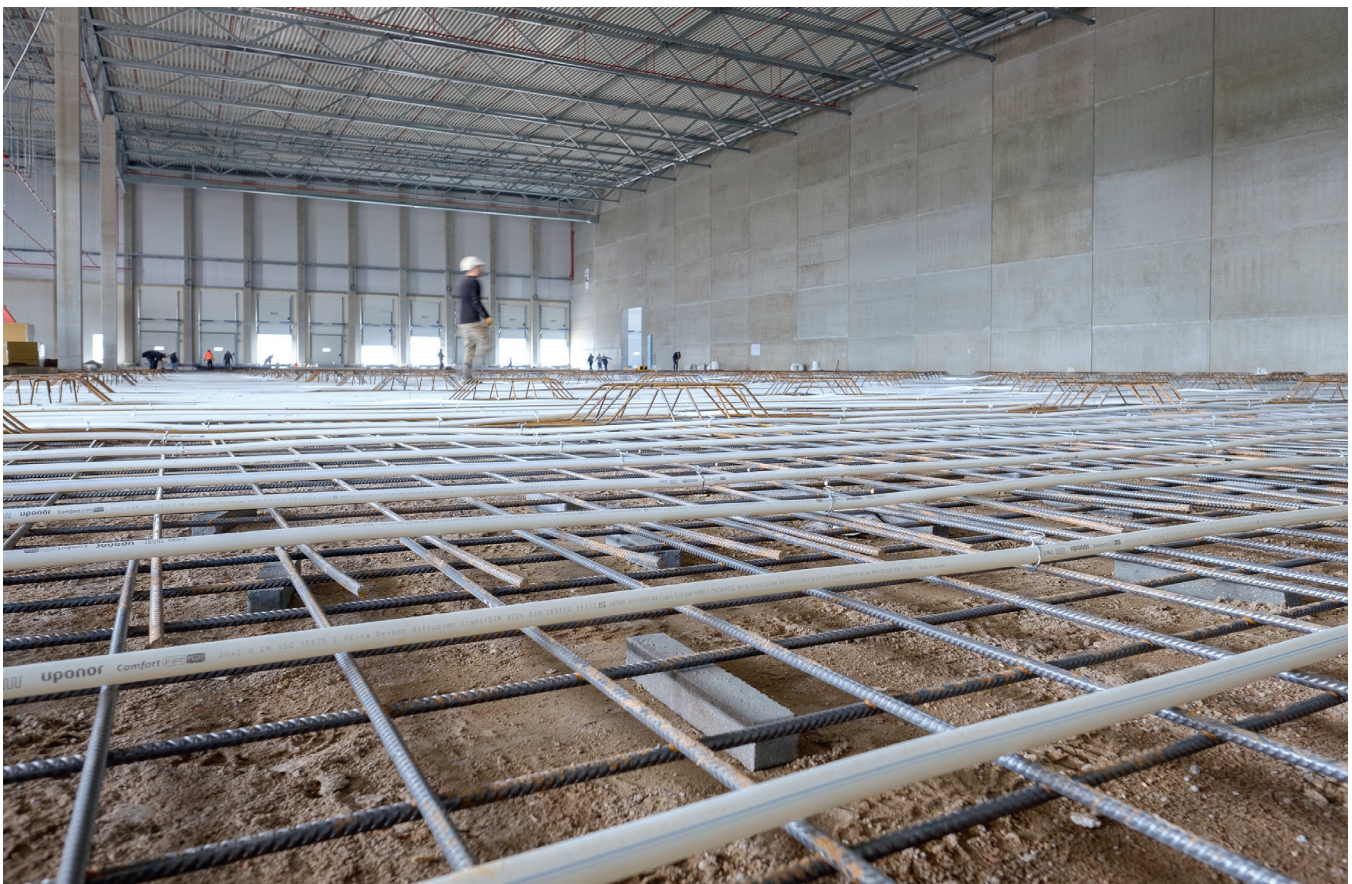
RUIM 200 KILOMETER UPONOR COMFORT PIPE PLUS LEIDING VERWERKT IN DE VLOEREN
