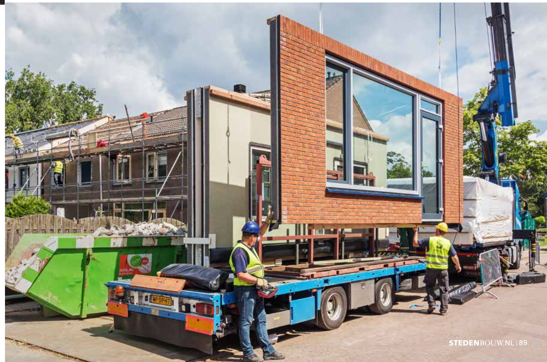
Om de woningen beter te isoleren, krijgen ze een volledig nieuwe buitenschil.
