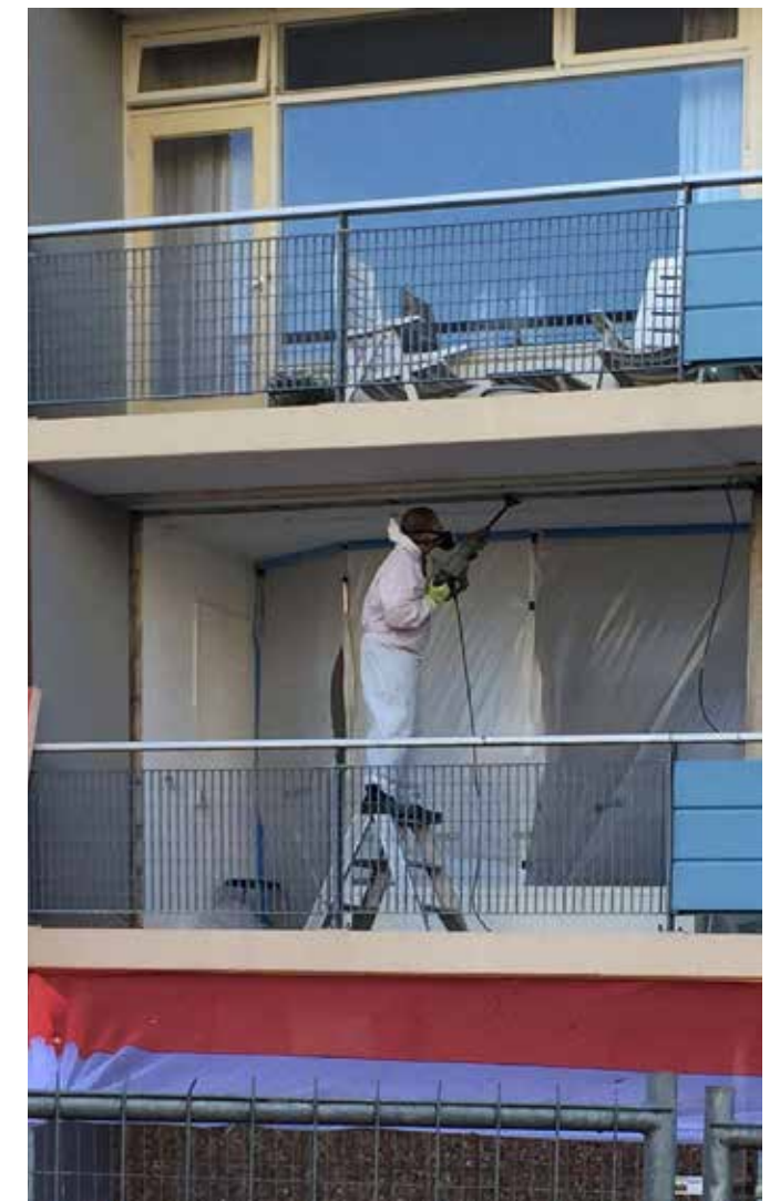
In de oude gevels zit asbest, dat zorgvuldig gesaneerd wordt. Pas nadat de gevels weer zijn vrijgegeven komt het treintje voor het groot onderhoud in werking.
