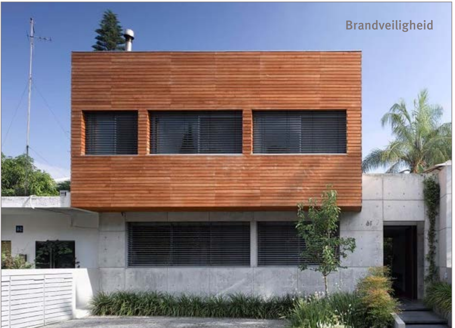
Figuur 1. Houten gevelbekleding in de woningbouw. Bron: www.gevelbekleding.nl/houten-gevelbekleding .
