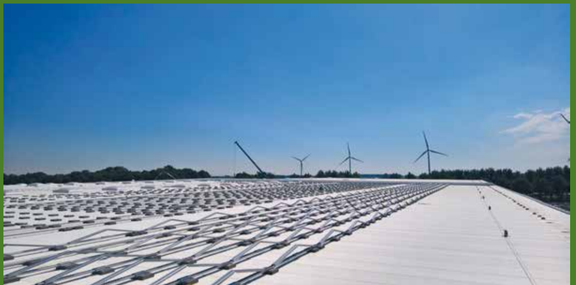
Op het dak zijn 4.000 dunne film pv-panelen gemonteerd. Deze foto is uit juli, toen de installatie nog in aanbouw was. Bron: Lidl
