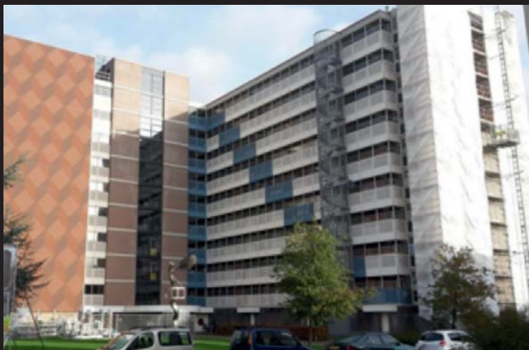
Isoleren kopgevel, afwerking met steenstrips in blokpatroon (foto's: Nijhuis en SWZ)
