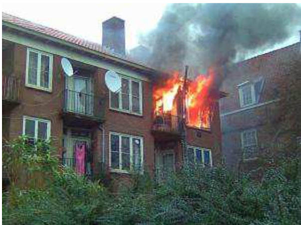
Figuur 1.2 Compartimentsbrand in een woonfunctie. De compartimentsbrand kan als uitgangspunt van de publiekrechtelijke regelgeving gezien worden
