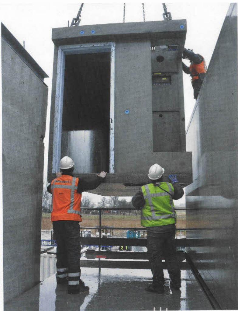
Tijdens de bouw is gewerkt met prefab cellen die het bouwproces ter plekke aanzienlijk hebben versneld.
