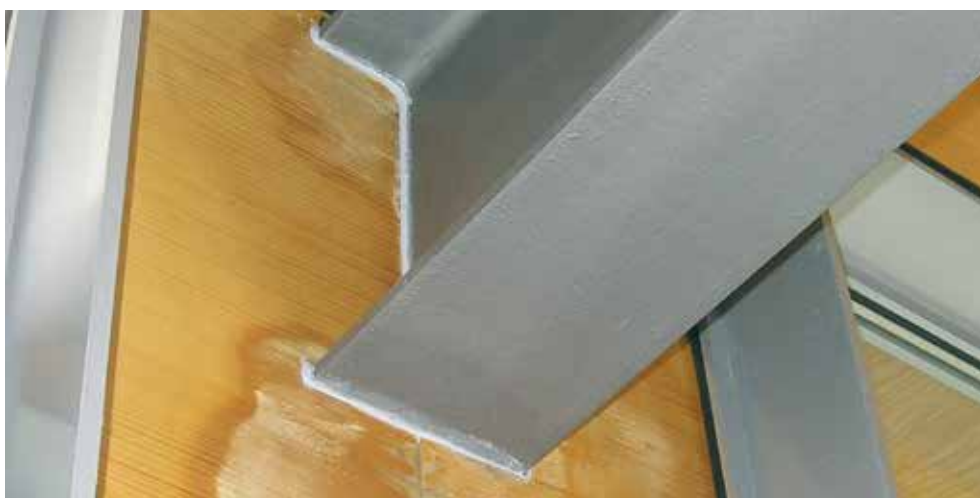
Afbeelding 14: Aansluiting van een staalconstructie op de gevel.
