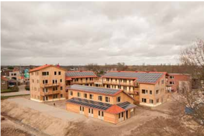
De bewoners hebben samen met vele vrijwilligers de strobalen zelf in de wanden (en daken) aangebracht.
