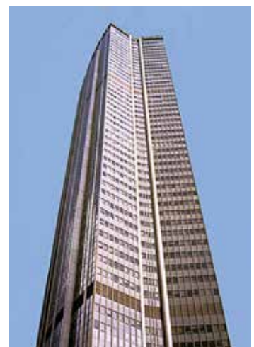
HOOGBOUW IN HET BUITENLAND: TOUR MONTPARNASSE IN PARIJS.
