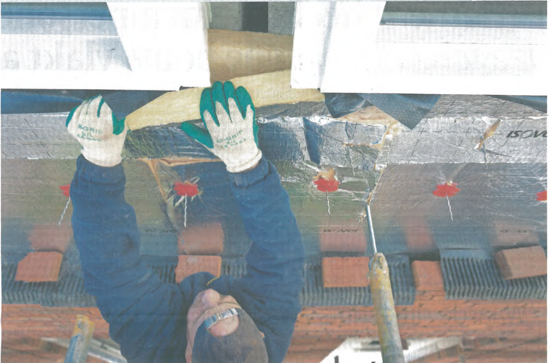
Een bouwvakker brengt isolatiemateriaal aan in de gevel van een nieuwbouwwoning in Oud-Beijerland. Foto: Hollandse Hoogte/David Rozing
