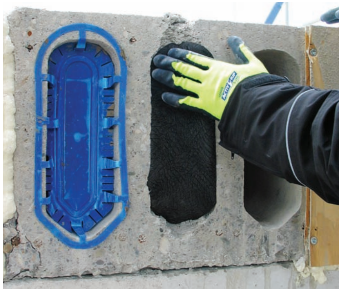
Multifunctionele afdichting van kanaalplaatvloer (foto: Celdex)
