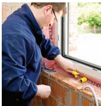
'Dichtrollen' van lucht- en dampdichte tape bij Passiefkozijn (foto: Soudal)
