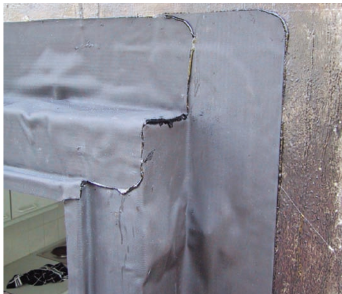
Luchtdichte afwerking met zelfklevende EPDM-strook. Let op: bij afplakken geen bouwvocht in het (stel)kozijn insluiten (foto: Carlisle CM Europe)
