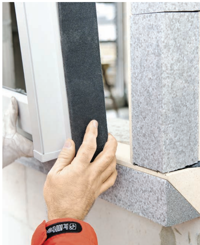
Montage van kozijn in verlijmd raamkader van hardschuim (foto: Tremco Illbruck)
