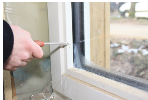
Signaleren van luchtlekken met behulp van rookstaafje.
