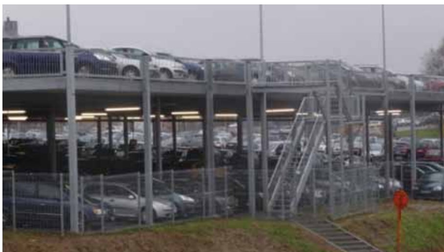
Figuur 2. Parkeergarage Jette (Academisch ziekenhuis Brussel). Een zeer open parkeergarage waarin flashover tot een volledig ontwikkelde brand uitgesloten is.
