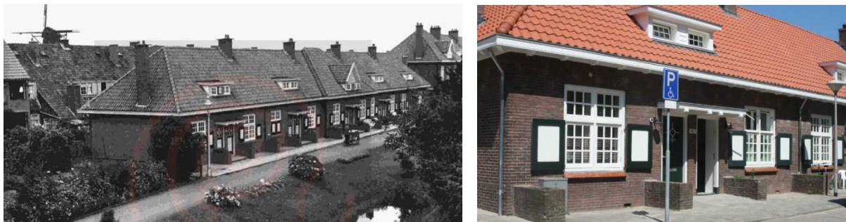
Figuur 30: Passief renovatie Binnengasthuisstraat Zwolle (woningcorporatie Openbaar Belang te Zwolle)
