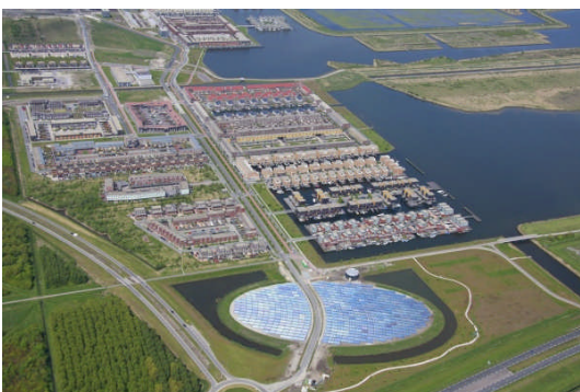
Figuur 10: Opwekking duurzame zonne-energie, zoneiland Almere
