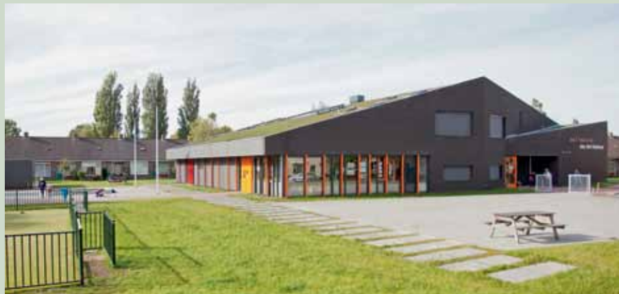
De Brede School in Jirnsom dient als thuis voor een aantal gebruikers, wat het tot een zeer compacte faciliteit maakt.
