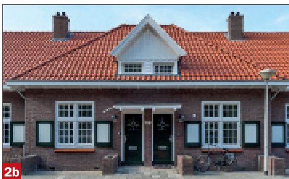
De woningen zijn waar nodig 'teruggerestaureerd' om ongewenste ingrepen uit de jaren '70/'80 ongedaan te maken. De installaties zijn zo ingepast, dat alle doorvoeren op het achterdakvlak uitkomen. Ondanks het traditionele beeld is ook bij de dakkapellen een hoge isolatiewaarde en goede luchtdichtheid gerealiseerd (foto VillaNova)
