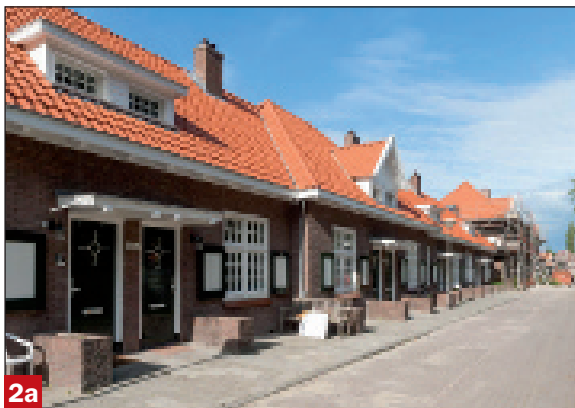
Passief renoveren van de monumentale 'Binnengasthuizen' in Zwolle voor Openbaar Belang. In de oorspronkelijke kozijnen heeft architect Andries Laane van VillaNova de roedeverdeling teruggebracht. Daar achter is een passief achterzetkozijn geplaatst met triple glas (foto VillaNova)
