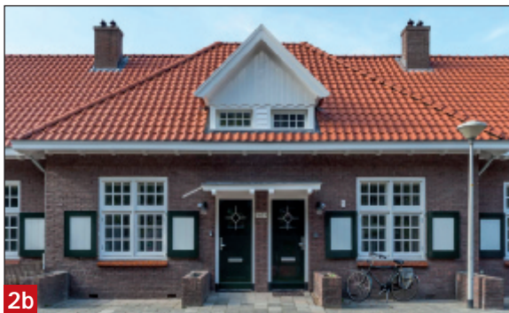
De woningen zijn waar nodig 'teruggerestaureerd' om ongewenste ingrepen uit de jaren '70/'80 ongedaan te maken. De installaties zijn zo ingepast, dat alle doorvoeren op het achterdakvlak uitkomen. Ondanks het traditionele beeld is ook bij de dakkapellen een hoge isolatiewaarde en goede luchtdichtheid gerealiseerd (foto VillaNova)
