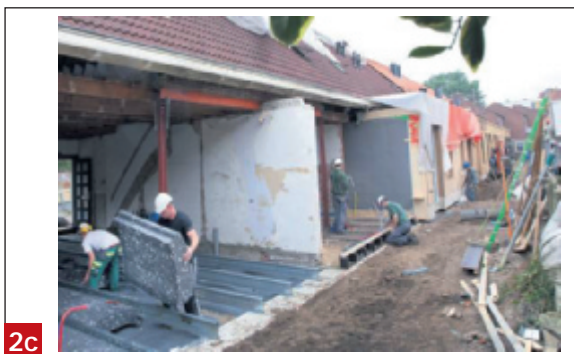
Vervangen van de begane grondvloer door een nieuwe lichtgewicht vloer; de oorspronkelijke uitbouw is gesloopt (foto Dura-Vermeer)
