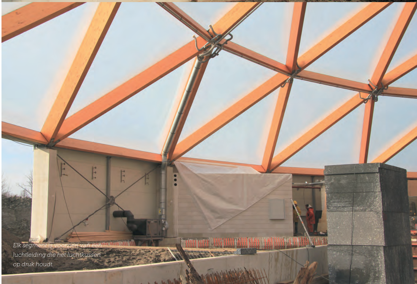
Aan de oostzijde is een deel van de koepel afgesneden en is een wand van polycarbonaat geplaatst.
