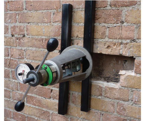
Het meten van de uittrekwaarde van de spouwankers.
