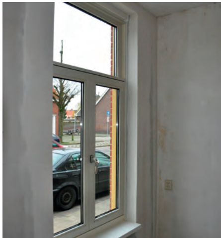
De kozijnen worden vastgeklikt in stelkozijnen. De negge wordt afgewerkt met Werdi-plaat.
