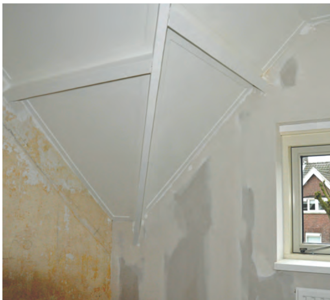
Met 70 mm dikke voorzetpanelen worden de binnenzijde van de gevels (type System) en de kapconstructie (type Basic) geïsoleerd.
