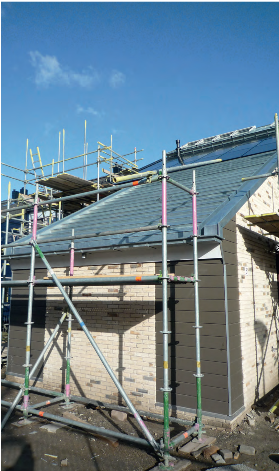
Met nieuw metselwerk en een zinken dak ondergaan de woningen ook esthetisch een volledige metamorfose.
