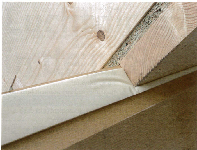
Aansluiting tussen kap en muurplaat met dichtingsband. Foto: Celdex.
