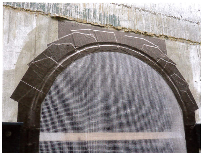
Aflakken stelkozijn met butylband.
