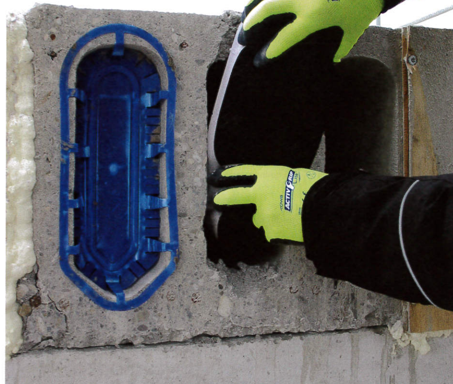
Vullingen ten behoeve van kanalen voor kanaalplaatvloeren. Foto: Celdex.
