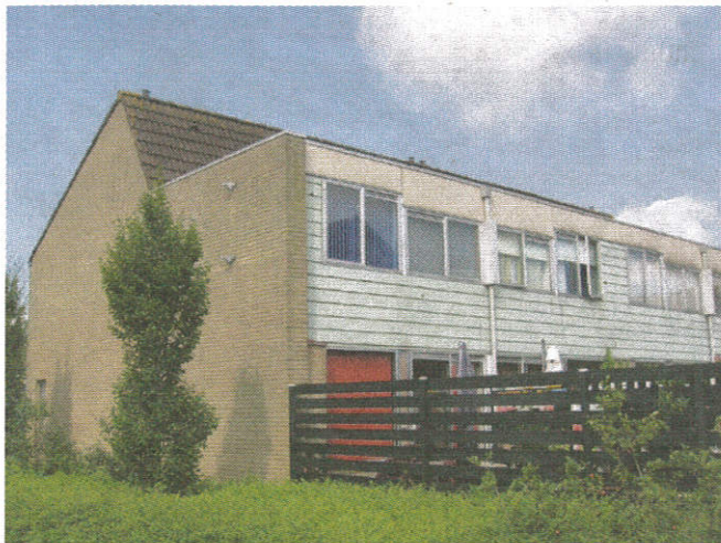
De woningen in Montfoort voor de renovatie.
