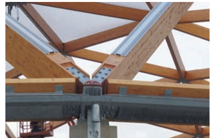
Het aluminium onderprofiel is geschroefd op de houten ribbe. Nadat de folie met een klikprofiel is vastgeklemd, sluit een aluminium deksel het detail af.
