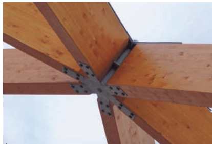
Een veldknooppunt van onderaf gezien. De schetsplaten zijn hier niet ingelaten, omdat ze niets in de weg zitten.
