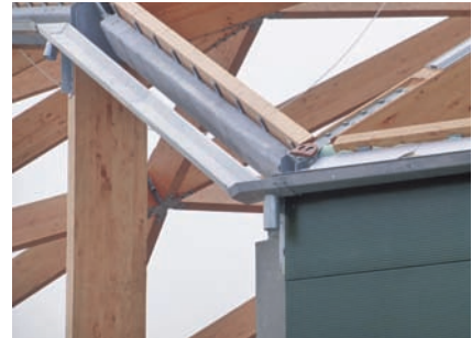
Hemelwater wordt opgevangen in een gootconstructie die parallel loopt aan de trekkring.
