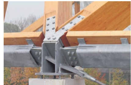
Eén van de randknooppunten met de stalen schoenen en de aanzet van een windverband. De stalen koker links en rechts van de schoen is de trekkring.
