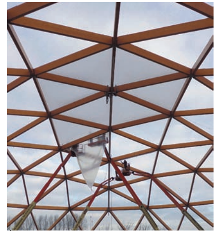
De zes driehoeken in het hart van de koepelconstructie zijn al gedicht met kussens en aangesloten op het luchtbehandelingsstelsel.
