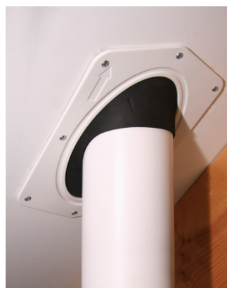
Aansluitingen aftapen, gebruik prefab manchetten bij doorvoeringen
