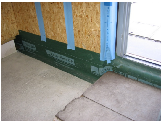
Aansluitingen aftapen, gebruik prefab manchetten bij doorvoeringen
