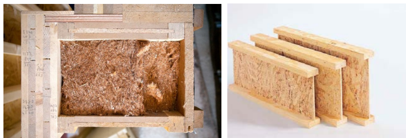
Gevelelementen bestaande uit houten I-liggers
