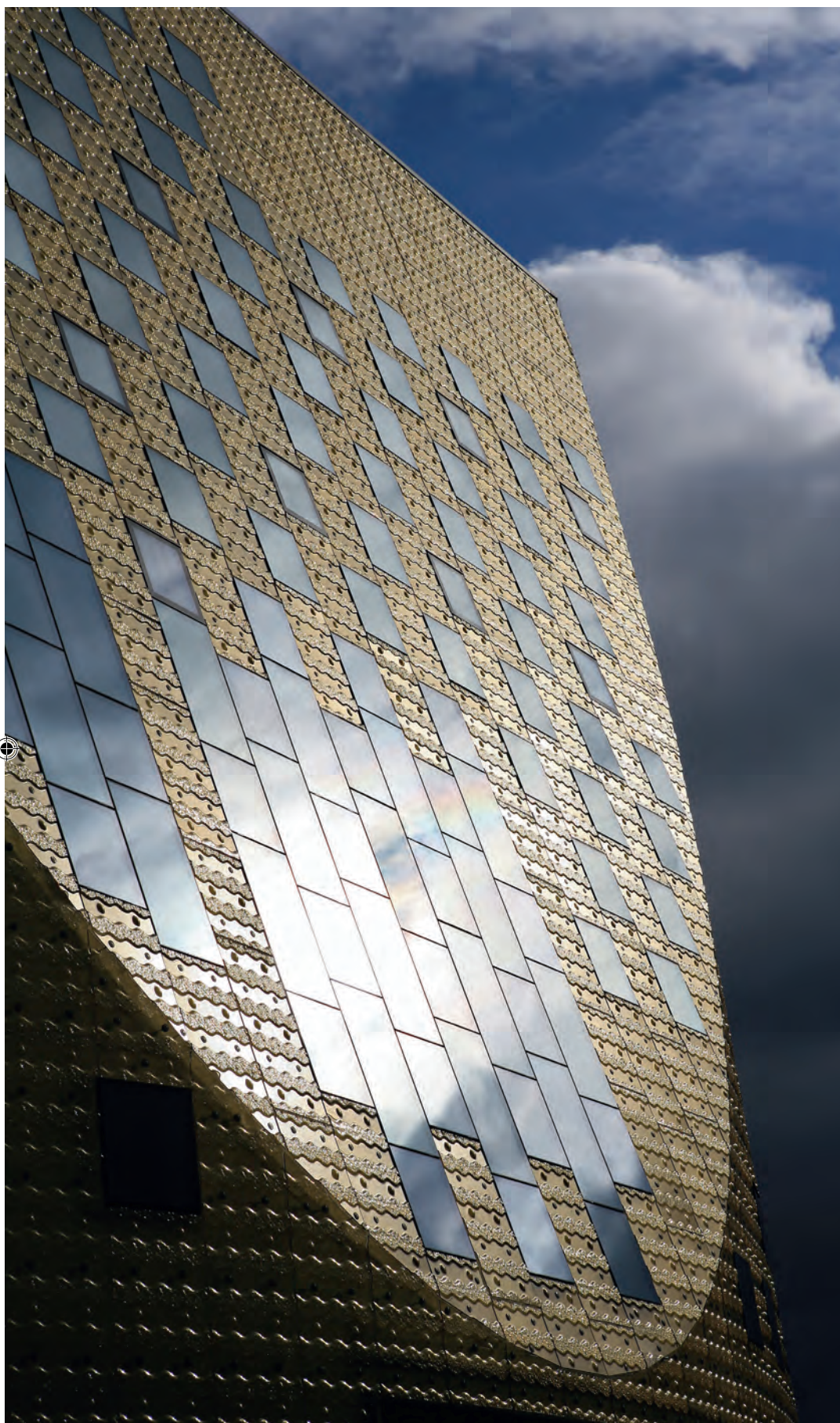
Het zes lagen hoge gebouw heeft aan de basis een ronde plattegrond, die naar boven toe eindigt in een vierkant. In de gevels leidt dit tot parabolisch gevormde vlakken.
