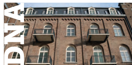
Appartementen in voormalig klooster // Locatie: Emmerikseweg, 's-Heerenberg // Opdrachtgever: Woonzorg Nederland // Bouwperiode: jan. 2011 – januari 2013
