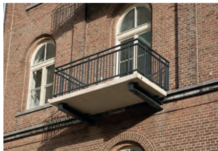
Het nieuwe balkon sluit aan bij de natuurstenen gevelband.
