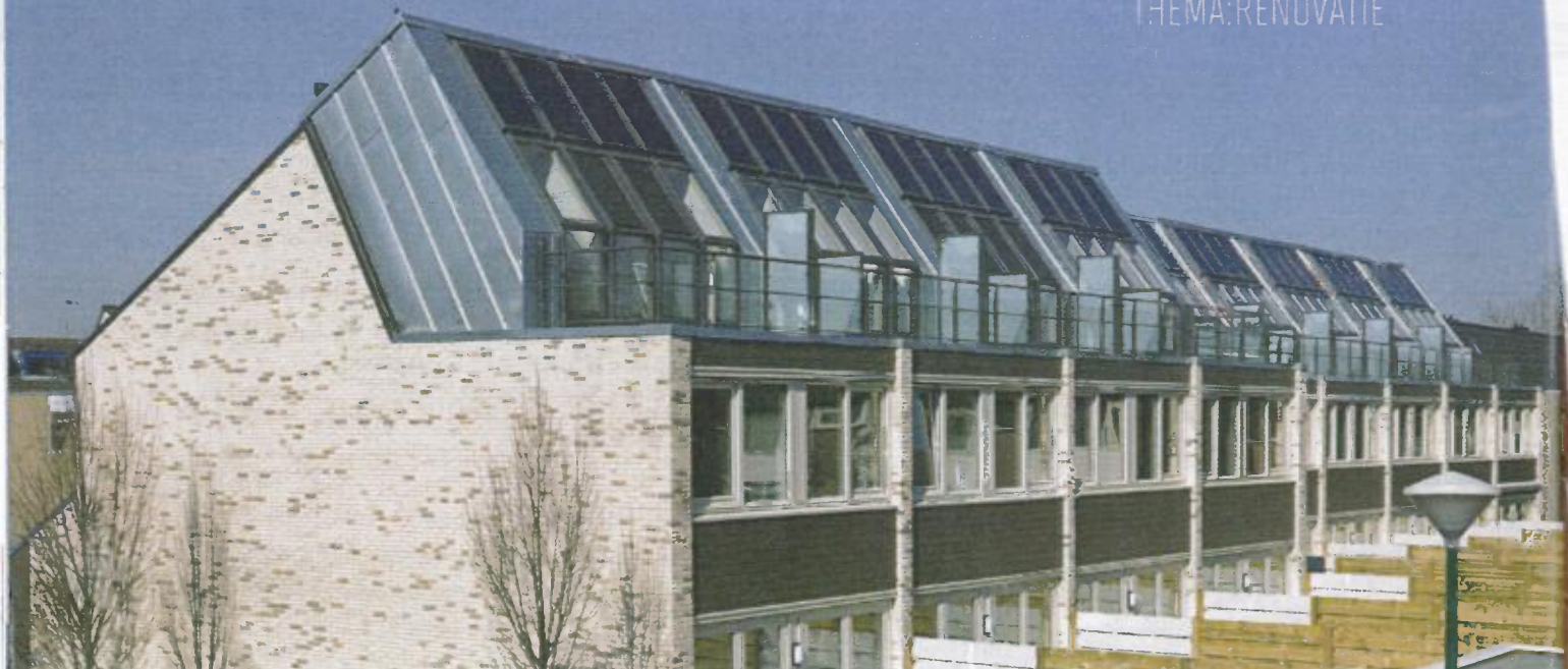
De woningen met het typische jarenzeventigdak tot bijna op de straat hebben nu een dakvlak dat energie opwekt.
