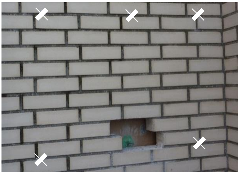
Nieman - Kettlitz Gevel- en Dakadvies
