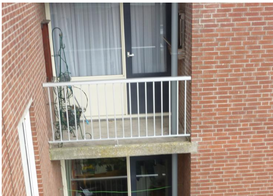
Nieman - Kettlitz Gevel- en Dakadvies
