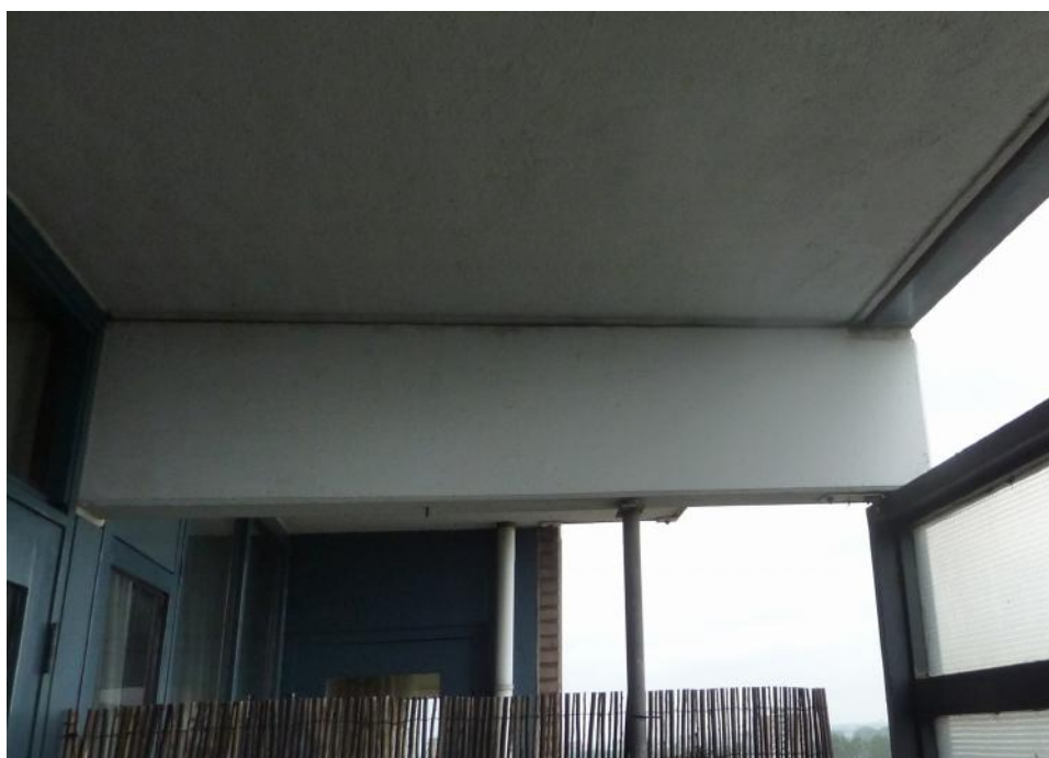
Nieman - Kettlitz Gevel- en Dakadvies
