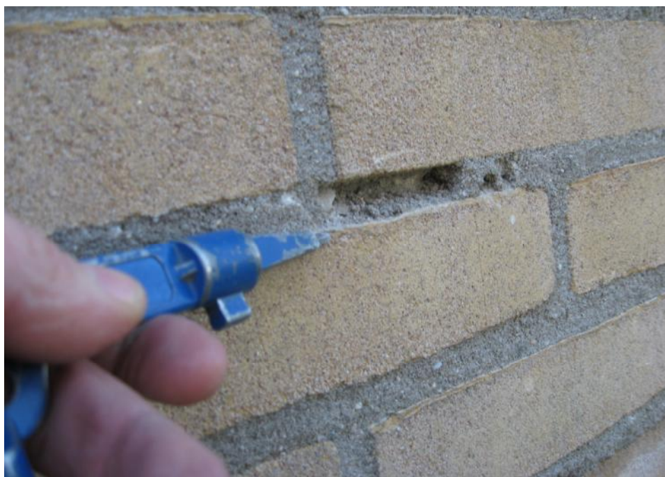
Nieman - Kettlitz Gevel- en Dakadvies
