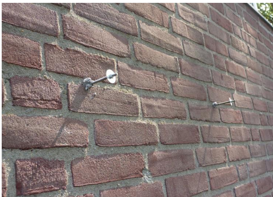
Nieman - Kettlitz Gevel- en Dakadvies
