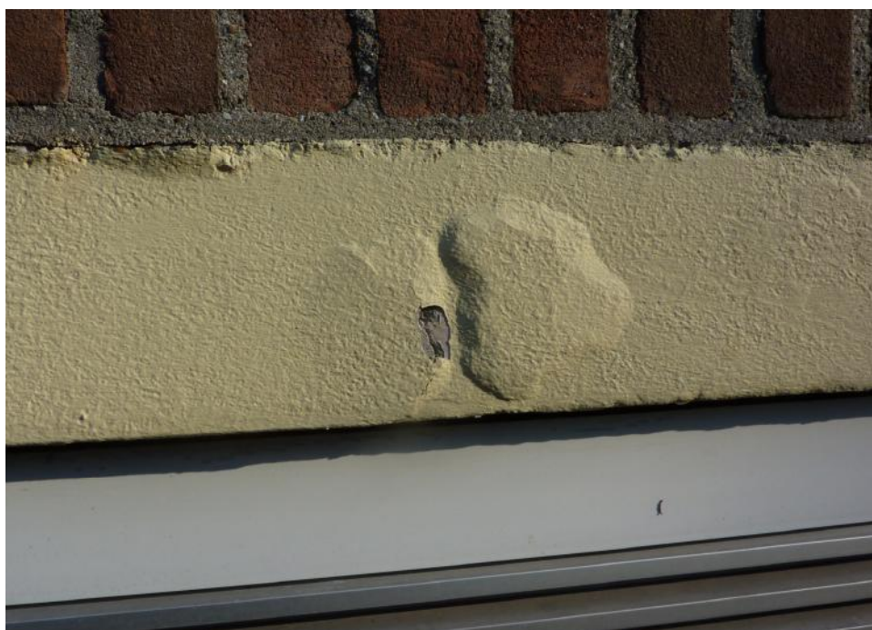
Nieman - Kettlitz Gevel- en Dakadvies
