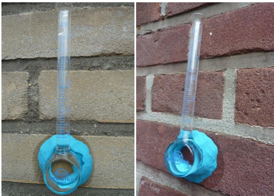
Nieman - Kettlitz Gevel- en Dakadvies
