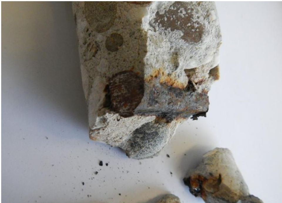
Nieman - Kettlitz Gevel- en Dakadvies
