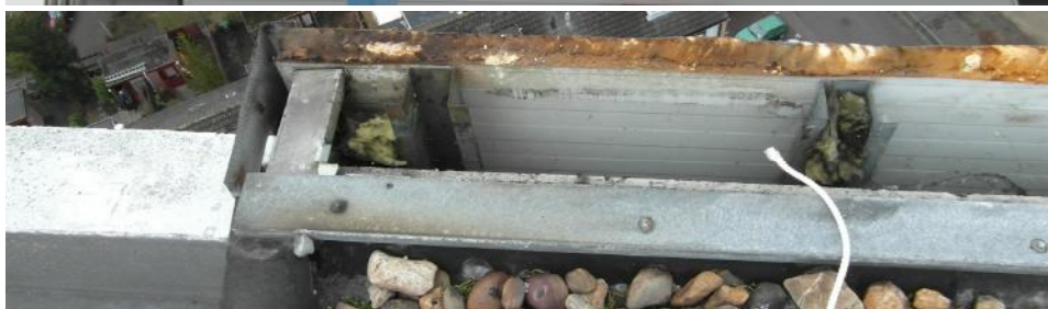
Nieman - Kettlitz Gevel- en Dakadvies
