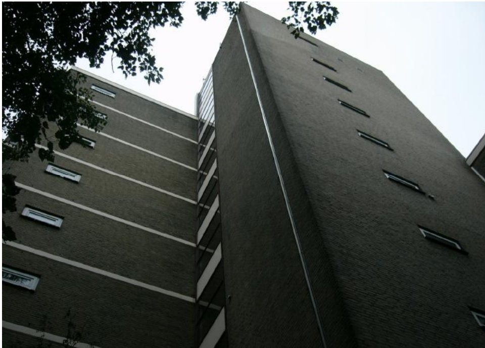
Nieman - Kettlitz Gevel- en Dakadvies
