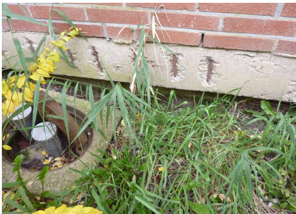
Nieman - Kettlitz Gevel- en Dakadvies
