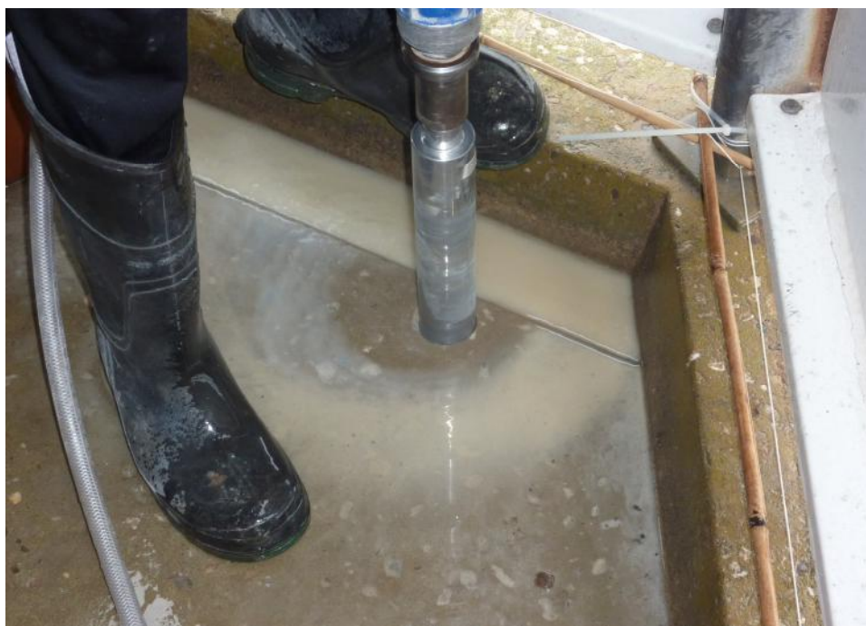
Nieman - Kettlitz Gevel- en Dakadvies
