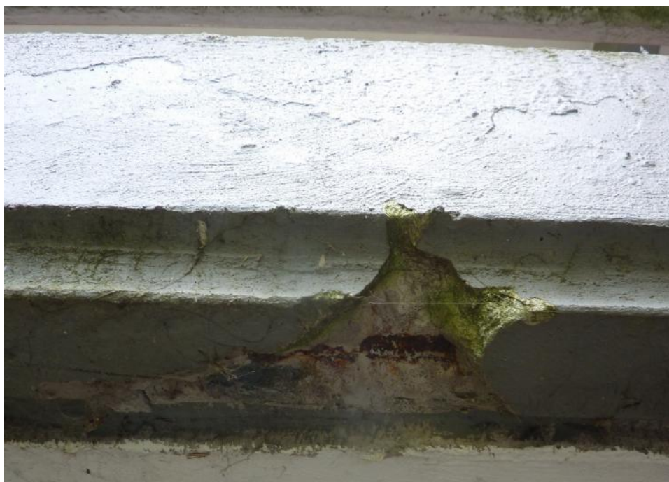
Nieman - Kettlitz Gevel- en Dakadvies
