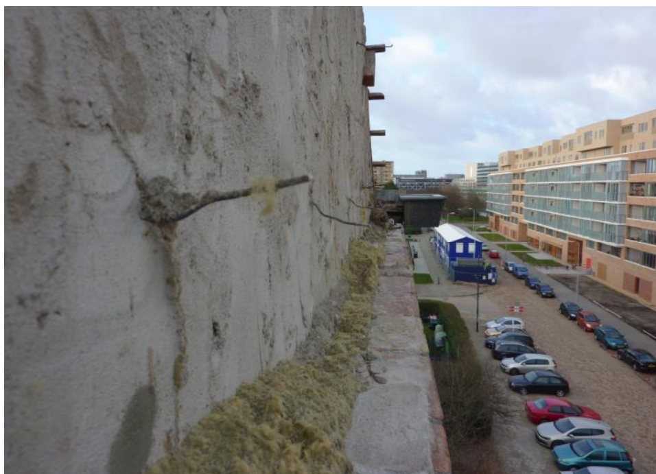
Nieman - Kettlitz Gevel- en Dakadvies
