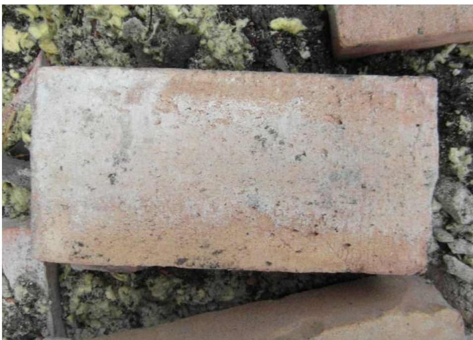
Nieman - Kettlitz Gevel- en Dakadvies
