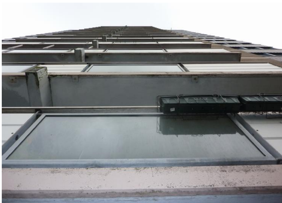
Nieman - Kettlitz Gevel- en Dakadvies
