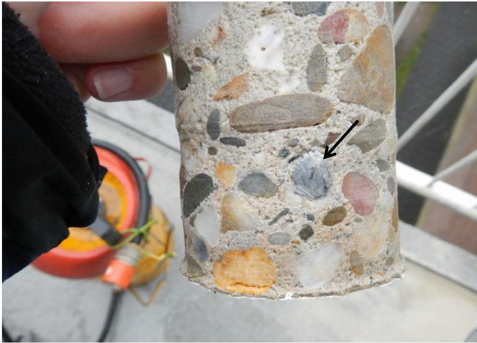
Nieman - Kettlitz Gevel- en Dakadvies
