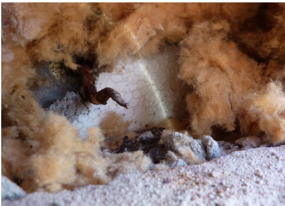
Nieman - Kettlitz Gevel- en Dakadvies
