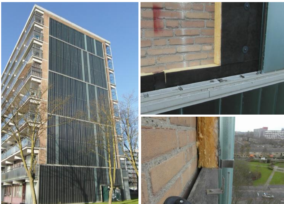
Nieman - Kettlitz Gevel- en Dakadvies
