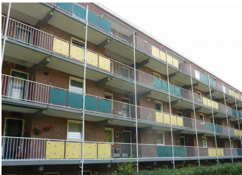
Nieman - Kettlitz Gevel- en Dakadvies
