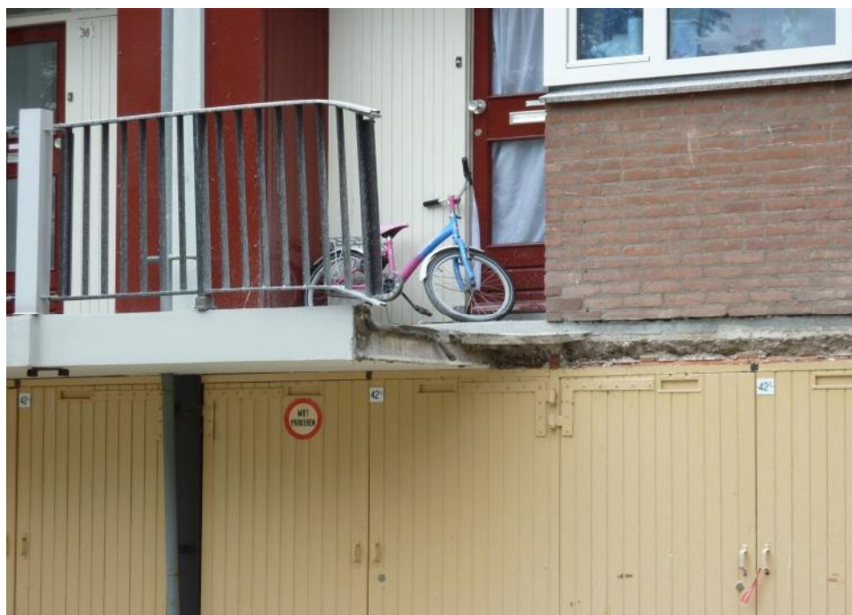
Nieman - Kettlitz Gevel- en Dakadvies
