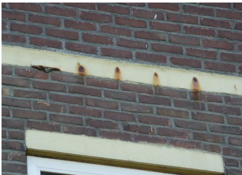
Nieman - Kettlitz Gevel- en Dakadvies
