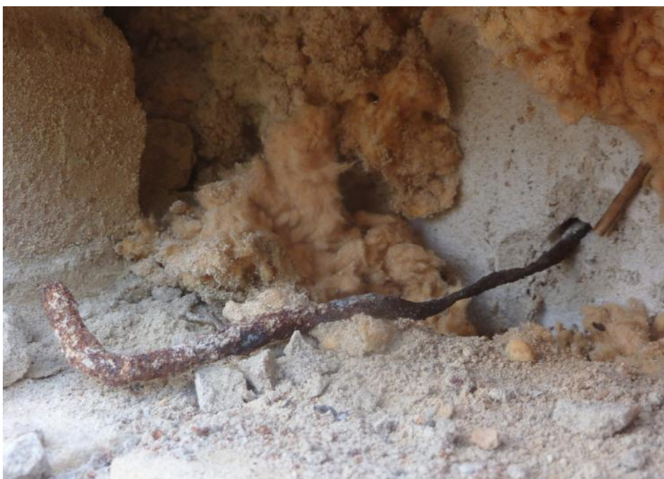
Nieman - Kettlitz Gevel- en Dakadvies
