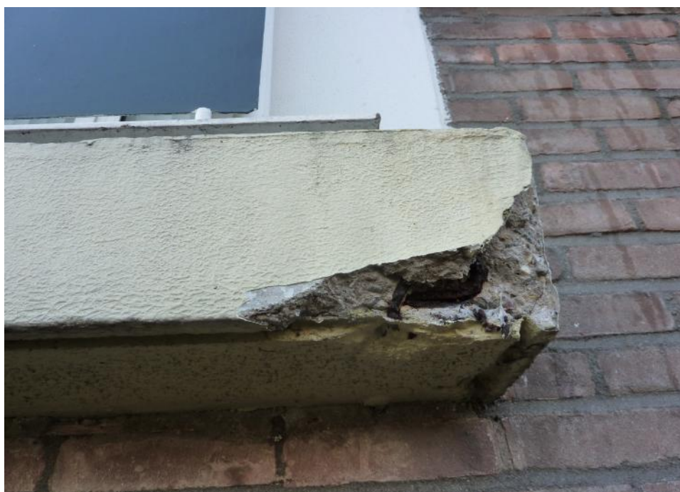
Nieman - Kettlitz Gevel- en Dakadvies
