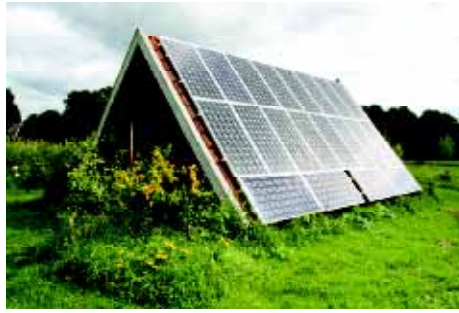
Aardappelschuur met zonnepanelen.
