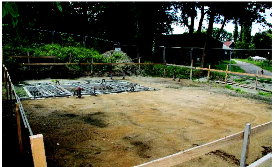
De Schoppe in aanbouw.
