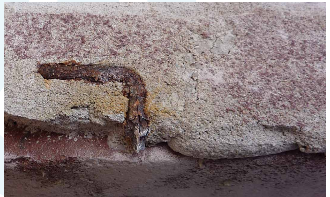
Doorgeroest spouwanker in buitenspouwblad
