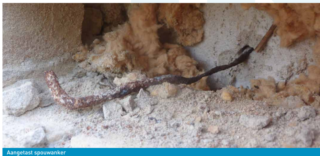
Aangetast spouwanker
