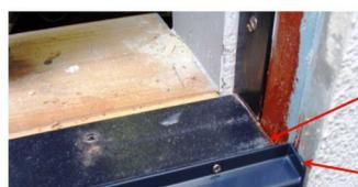
**Verduidelijk aandachtspunt van punt 7:** De kopse kanten van de ingekorte nieuw stelhout moet eerst worden behandeld met grondverf. De aansluiting stelkozijn met nieuwe onderdorpel wordt met een lijmende kit geseald. Mogelijk kan het sealen ook uitgevoerd worden met de daarvoor bestemde vuller.
