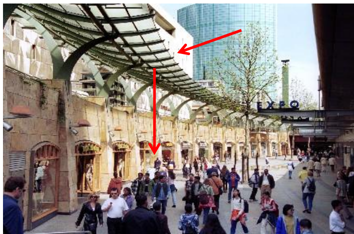
Bevestiging glasplaten overkapping winkelstraat... Risico?
