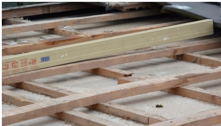
Panlatten functioneren nu onbedoeld als constructief element, Leidschenveen.
