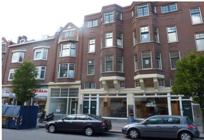
Non-destructief onderzoek, wooncomplex te Rotterdam.
