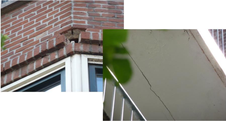
Zichtbare schade aan gevels en betonnen onderdelen, wooncomplex te Rotterdam.
