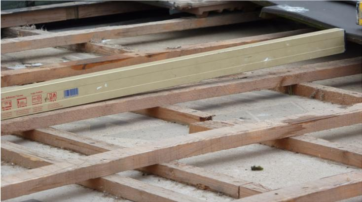
Panlatten functioneren nu onbedoeld als constructief element, Leidschenveen.
