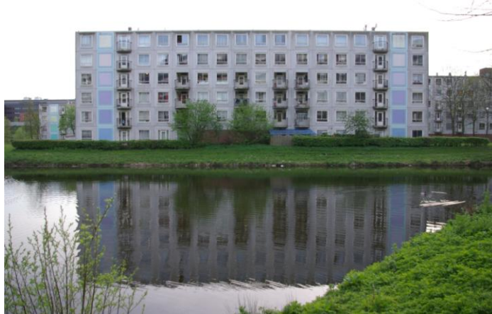
Bevestiging beton gevels langs grasstrook... Risico?
