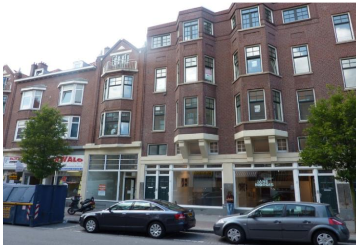
Non-destructief onderzoek, wooncomplex te Rotterdam.
