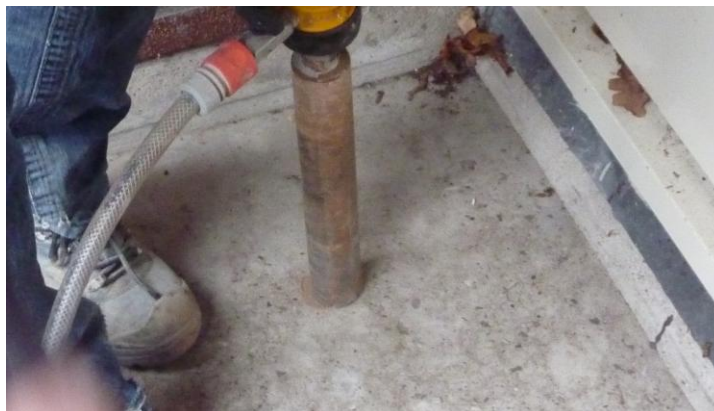
Analyse en destructief onderzoek betonnen balkons, uitboren testkern, Lelystad.
