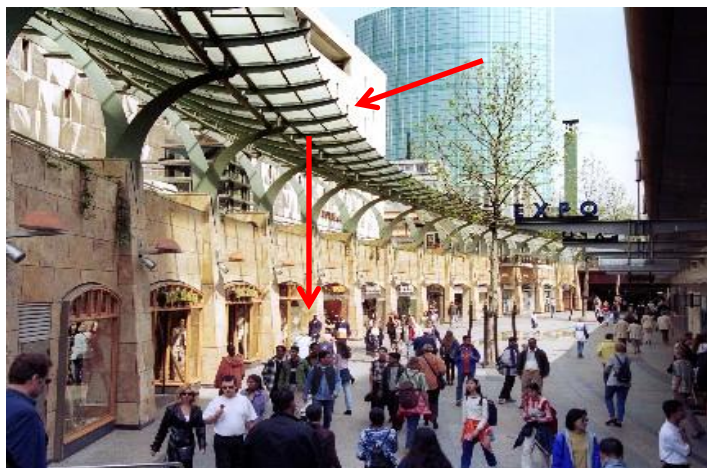
Bevestiging glasplaten overkapping winkelstraat... Risico?
