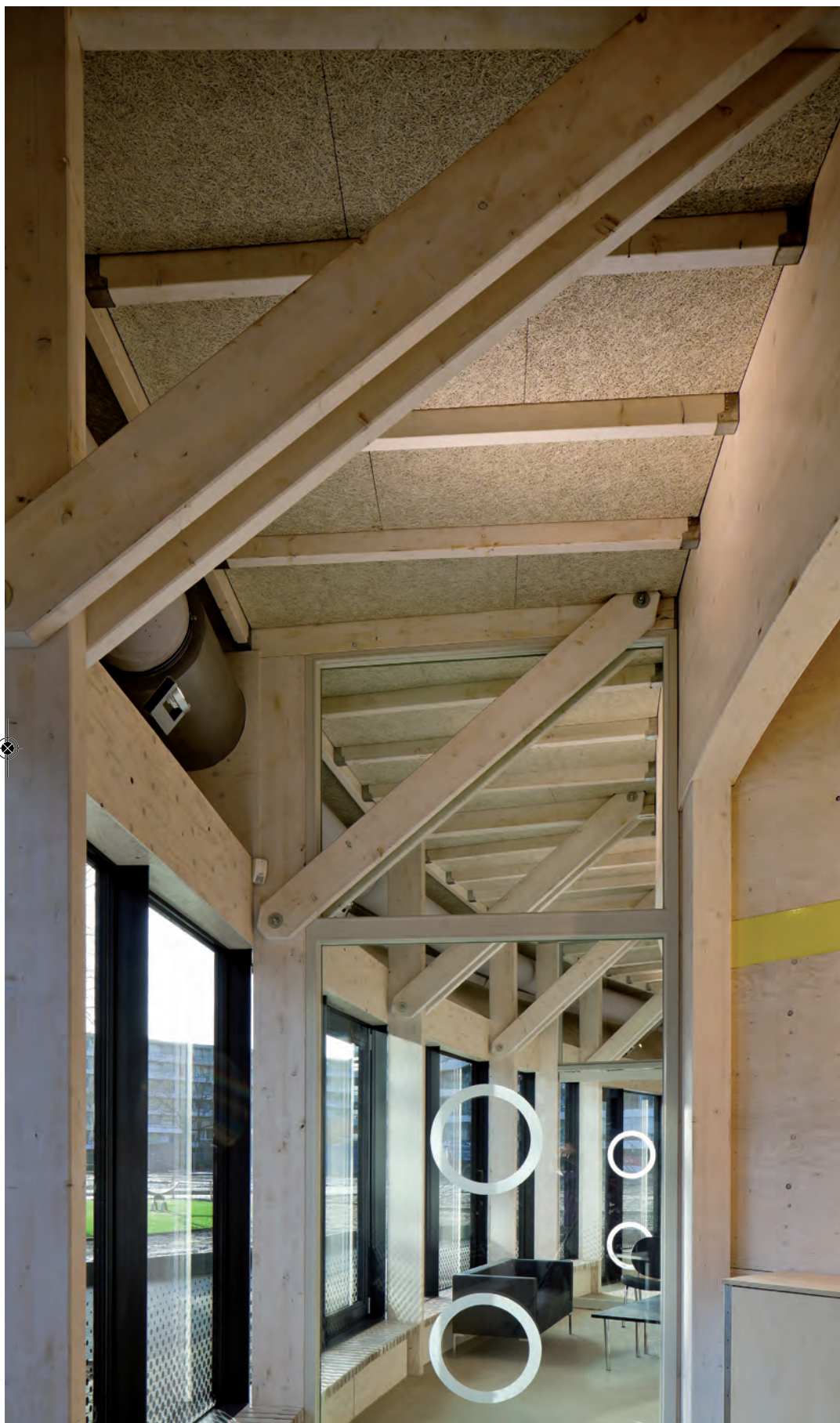
De schuine dakrand is als een soort fietswiel op pootjes rondom de stabiele houtconstructie van de gymzaal geplaatst.
