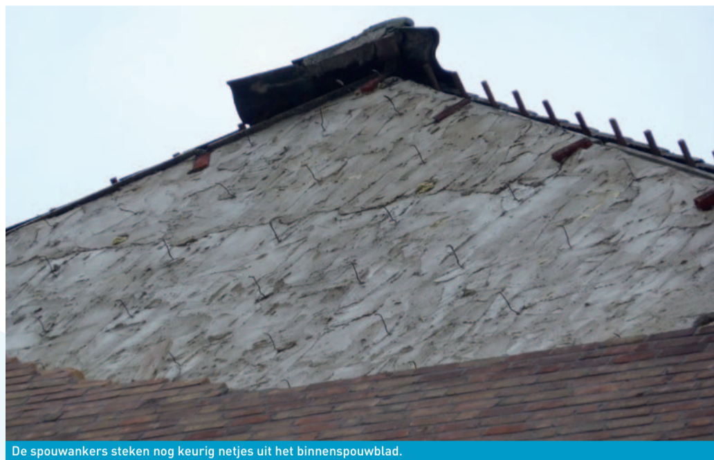
De spouwankers steken nog keurig netjes uit het binnenspouwblad.
