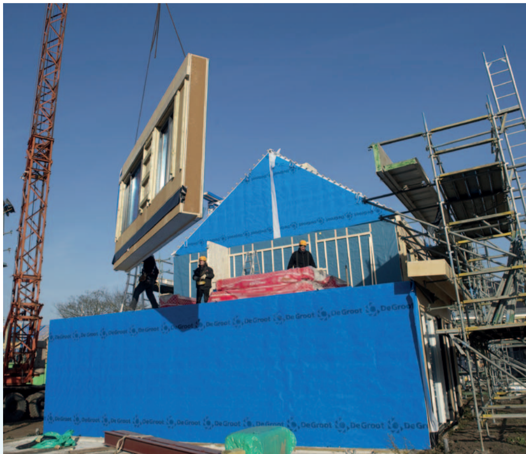
De elementen worden geprefabriceerd aangeleverd op de bouwplaats. Ze hebben daardoor een hoge kwaliteit, ook ten aanzien van de luchtdichtheid.
