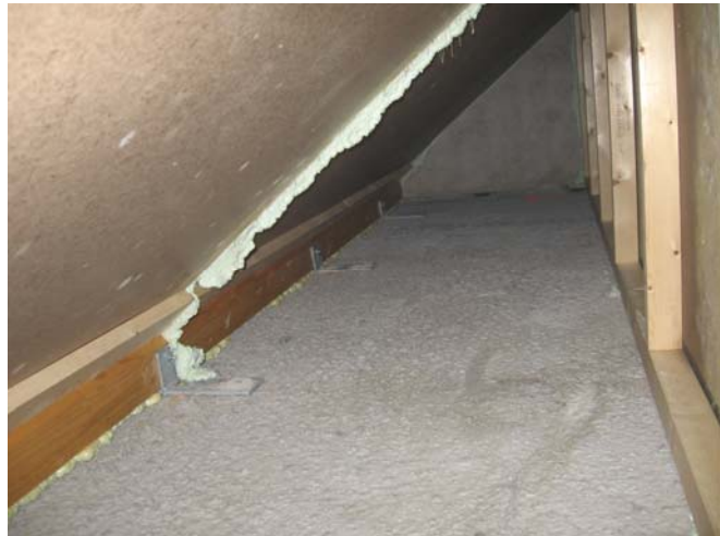
Ook op slecht bereikbare plaatsen (achter knieschot) dient een goede luchtdichting aanwezig te zijn. Bron: Adviesburo Nieman B.V.
