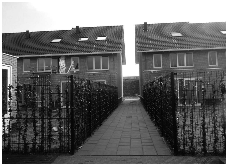
Figuur A 9200-9 Achterpadverlichting vereist. Ophangen aan de gevel? Foto Nieman Raadgevende Ingenieurs B.V.
