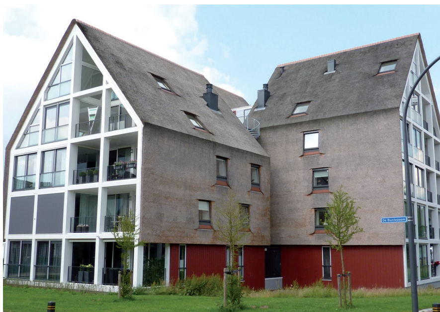
Figuur A 6010-3 Uitwendige scheidingsconstructies met een hellingshoek groter dan 75^\circ worden als gevel beschouwd. In het kader van de beoordeling van brandveiligheid wordt dus duidelijk onderscheid gemaakt tussen het verticale riet (gevel) en het schuingeplaatste riet (dak)
