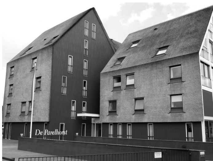
Figuur A 6010-12 Bij gebouwen waarbij riet in gevels wordt toegepast dient extra rekening te worden gehouden met brandveiligheid. Eventueel moet een gelijkwaardige brandveiligheid te worden aangetoond
