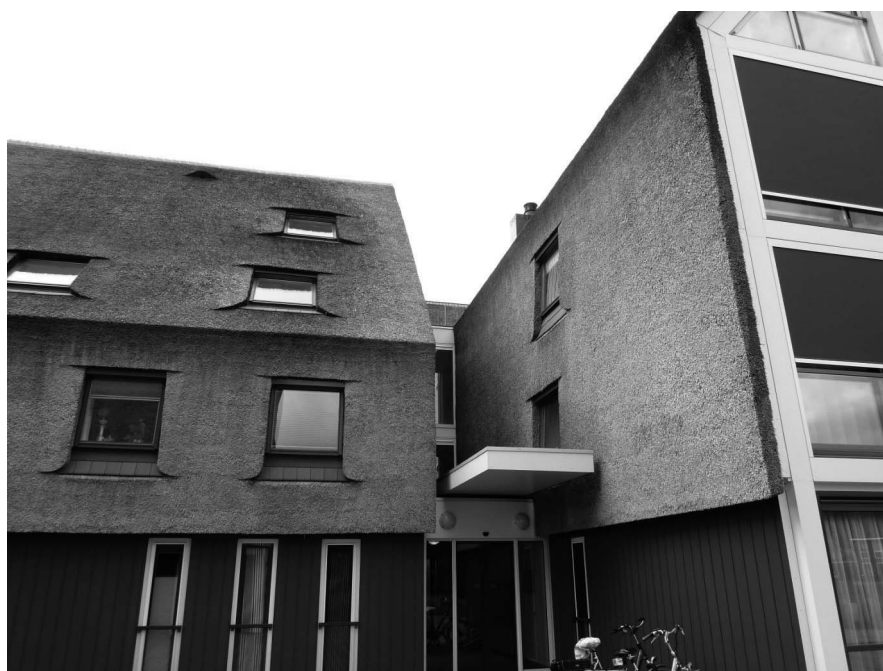
Figuur A 6010-6 Ook kan brandoverslag plaatsvinden van het ene bouwdeel naar het andere
