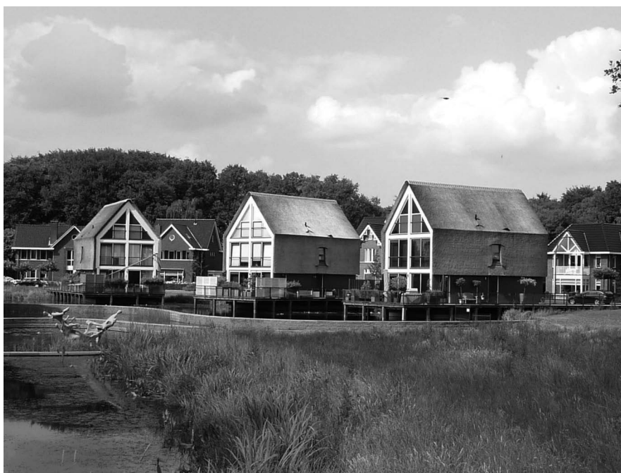
Figuur A 6010-1 Woningbouwproject 'De Bunte' te Nunspeet. Riet toegepast op daken maar ook in gevels
