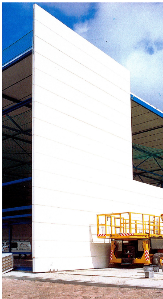
Voorbeeld van een stalen hal met gasbeton wanden en dak; wanden en dak zijn in dit geval niet als thermisch licht maar als thermisch zwaar te beschouwen.
