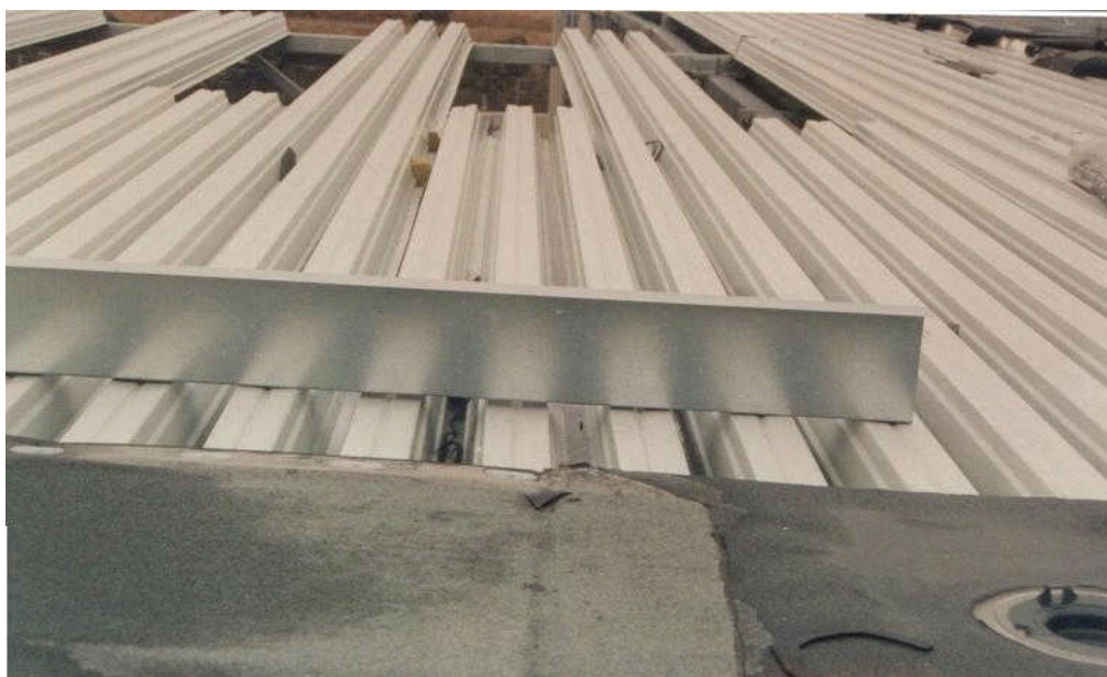
Voorbeeld van een thermische lichte dakconstructie
