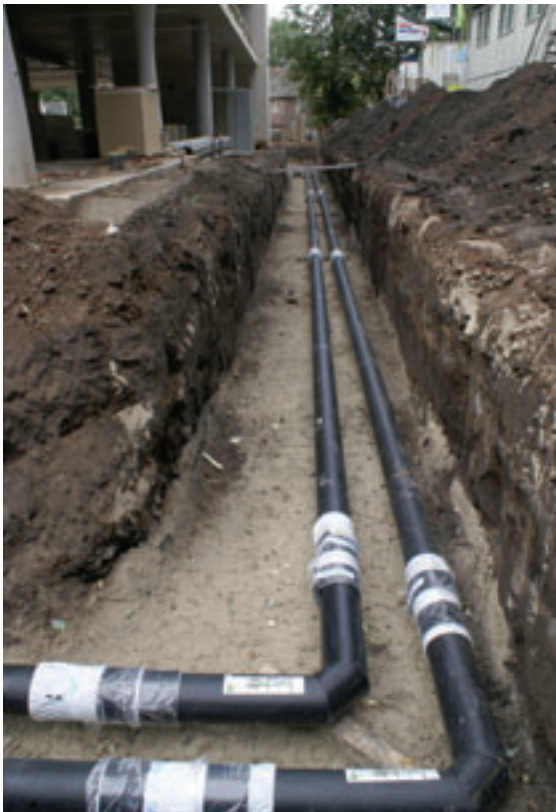
6. Aanleg warmtenet ROC van Twente (Hart van Zuid) te Hengelo (Anja Brokers e.o.).
