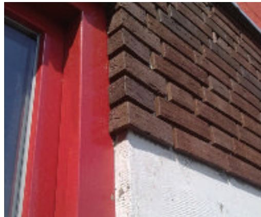
Figuur 4. Buitengevelisolatie met ingezaagde stenen. Bron: Adviesburo Nieman B.V.
