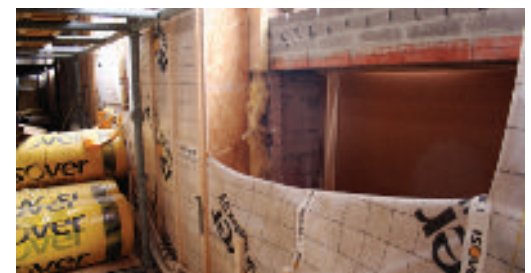
Figuur 6. Binnengevelisolatie niveau Passief restaureren voormalige Latijnse school te Middelburg. Bron: Paul Diersen, Eisma Bouwmedia.
