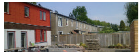
Figuur 2. Gevelisolatie renovatie Velve-Lindenahof: rechts oorspronkelijke gevel, links het aanbrengen van gevelisolatie. Bron: Adviesburo Nieman B.V. / De Woonplaats.
