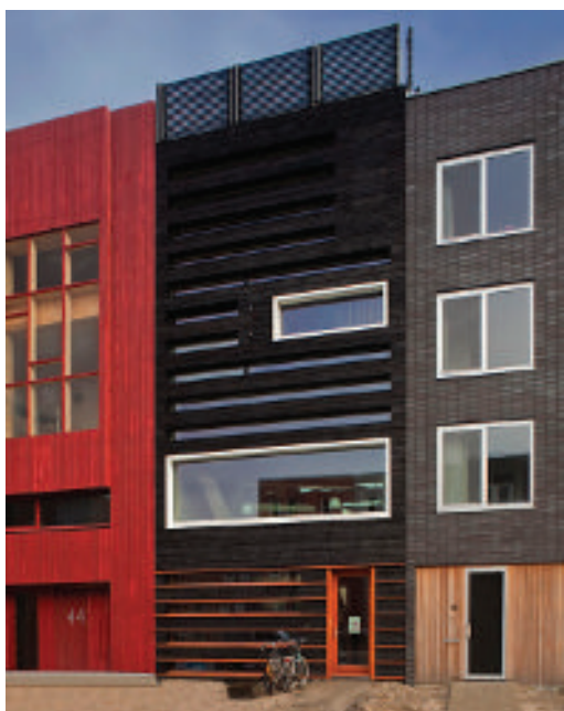
Figuur 1. Controle uitvoering gevelisolatie door middel van thermografie. Bron: Adviesburo Nieman B.V. /Woonhuis 2.0 Amsterdam, Faro architecten.
