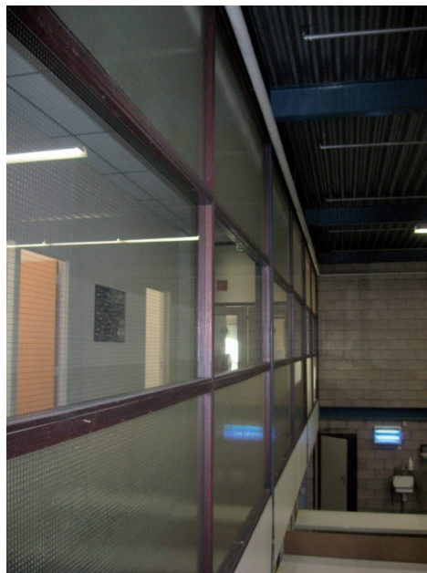
Figuur 3 – Scheidingen met veel draadglas werden vroeger als brandwerend beschouwd
