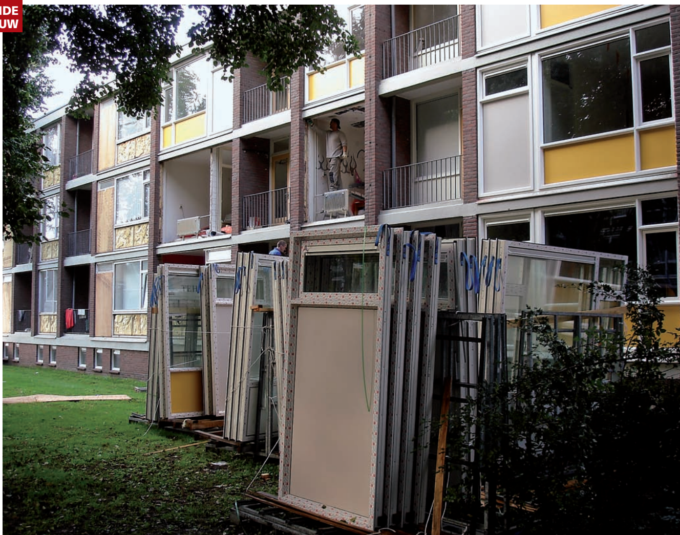
Woningverbetering (90 woningen) aan De Zoom in Ede.
