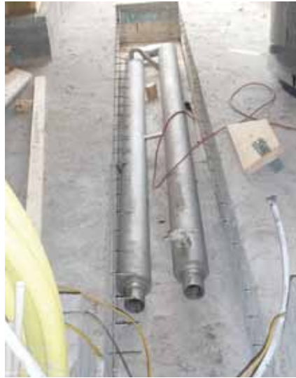
Riolering omgeven door een tweede pijp.
