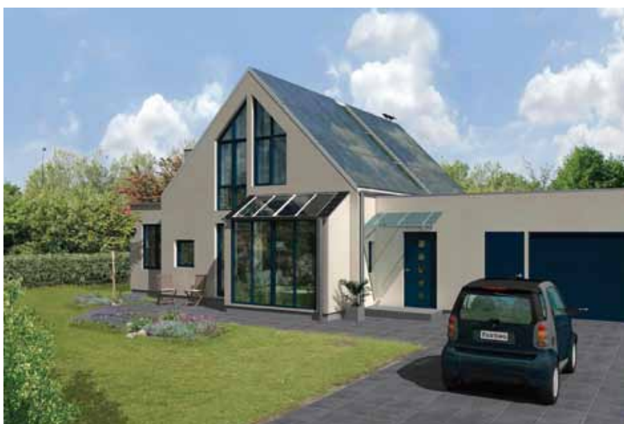
De westgevel van het energieplushuis in Malmö. Het dak met een hellingshoek van 45° is gericht op het zuiden en bedekt met PV-cellen.
